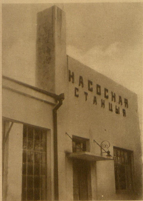
Помпавая станцыя менскай каналізацыйнай сеці
