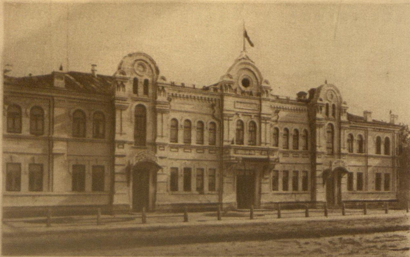
Агульны выгляд новага будынку
