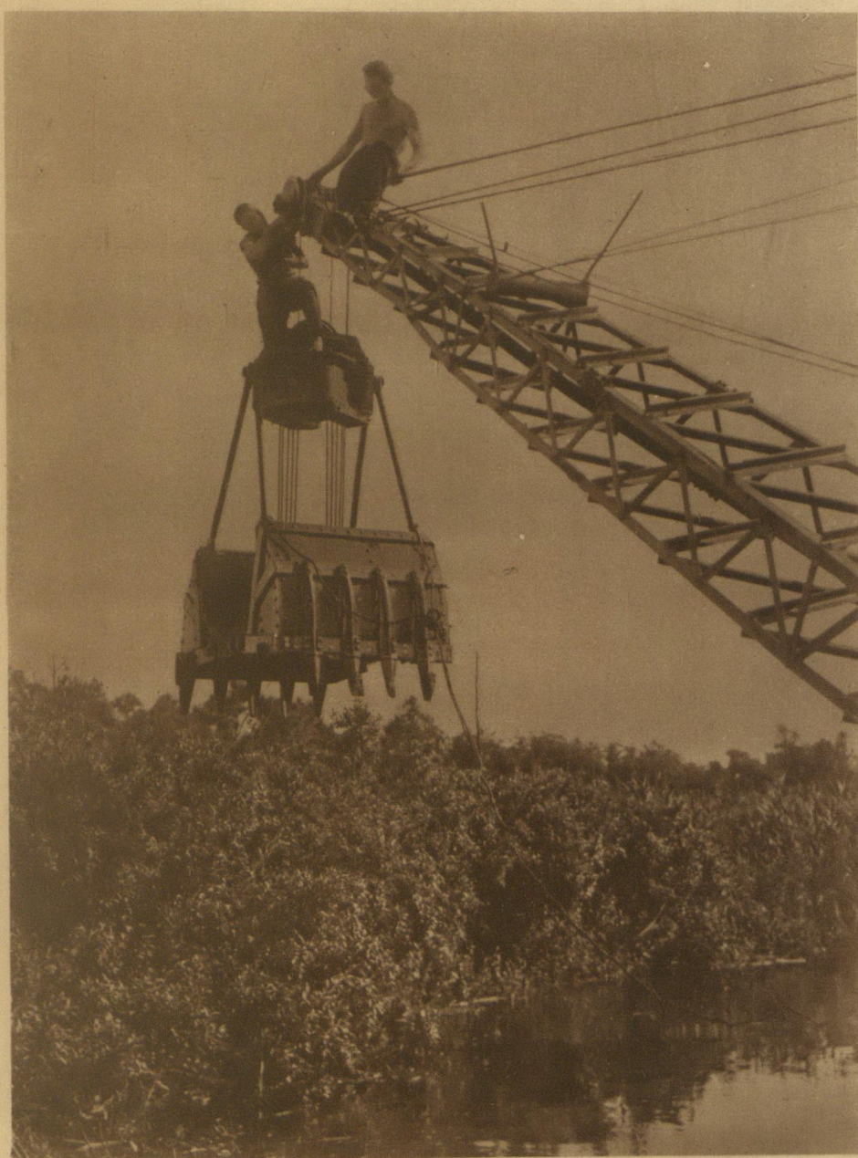
Зямлячарпалка на канале
