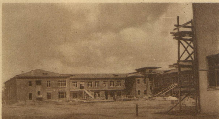
Адзін з корпусоў у пэрыодзе будаваньня
