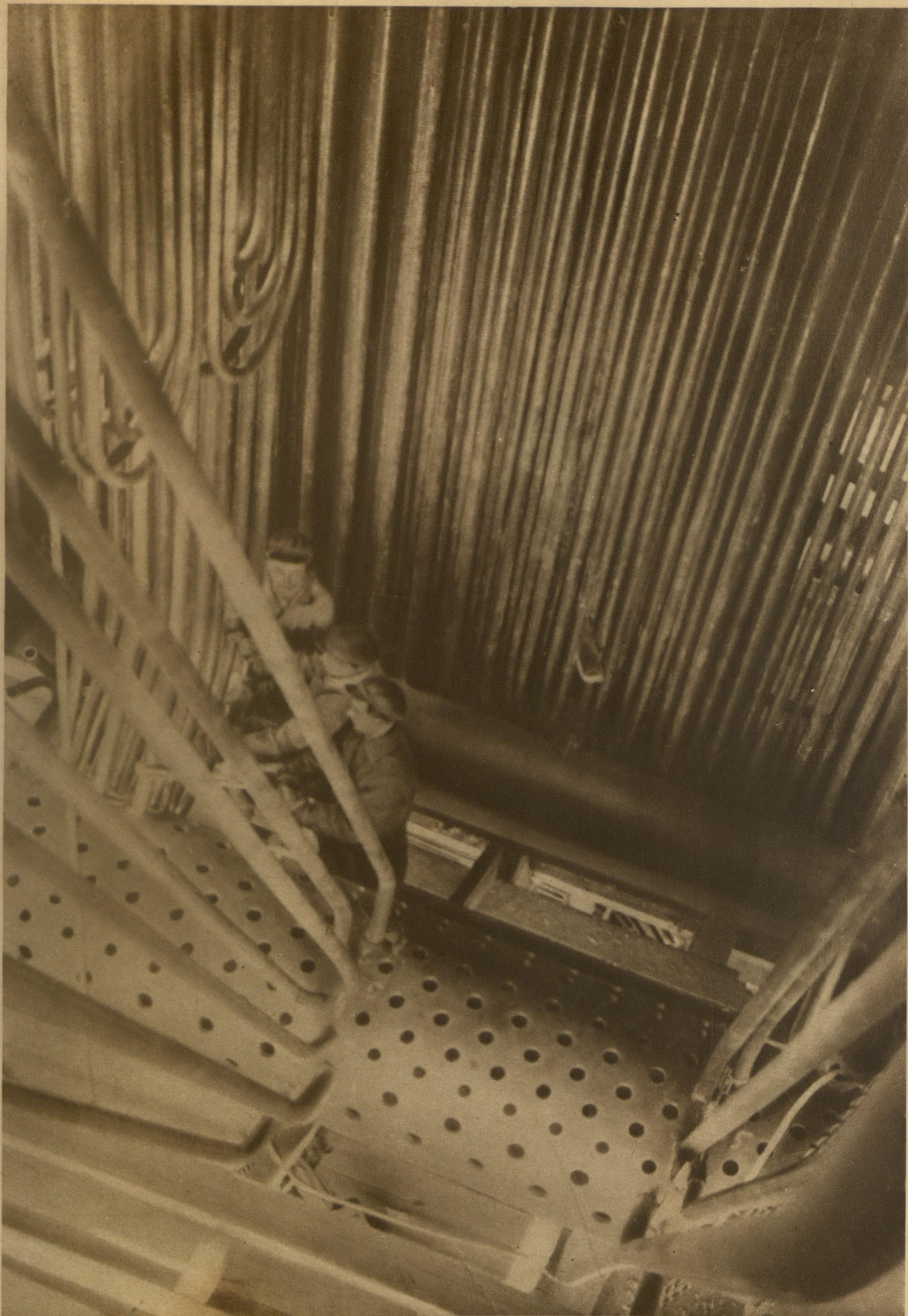
Монтаж трех паровых катлоу на 750 куб. м. кожны
