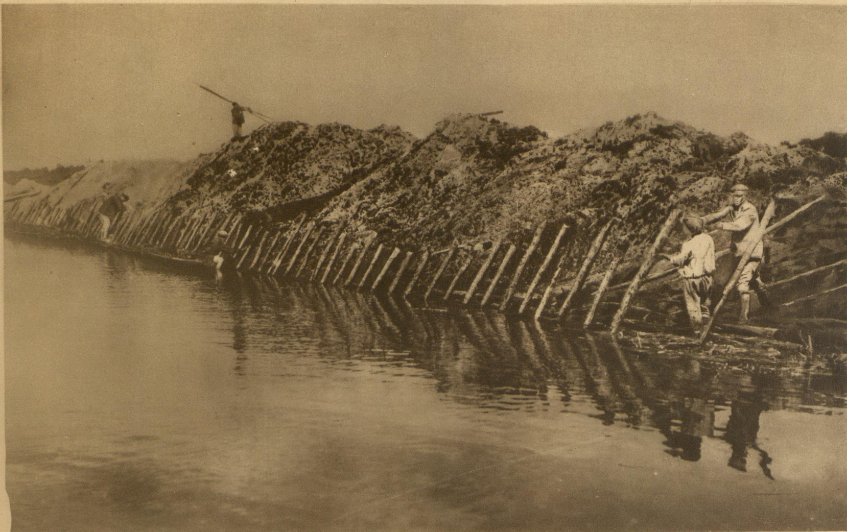
Плятнёвые работы на р. Аресе
